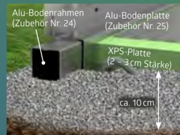
Mit dem **Alu-Bodenrahmen** können Sie das Gerätehaus auch auf einem Splittbett aufstellen und sturmsicher verankern (Bodenanker liegen bei). Die **Alu-Bodenplatte** dient als funktioneller Boden und wird mit XPS-Hartschaumplatten unterfüttert (nicht im Lieferumfang).
